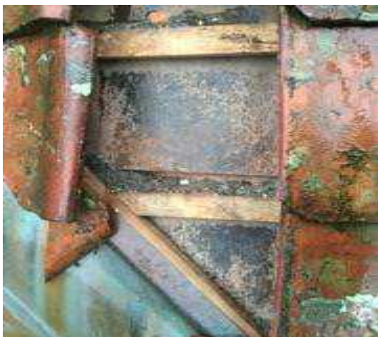
Tilstand på steiner og undertak kile sørøst.
